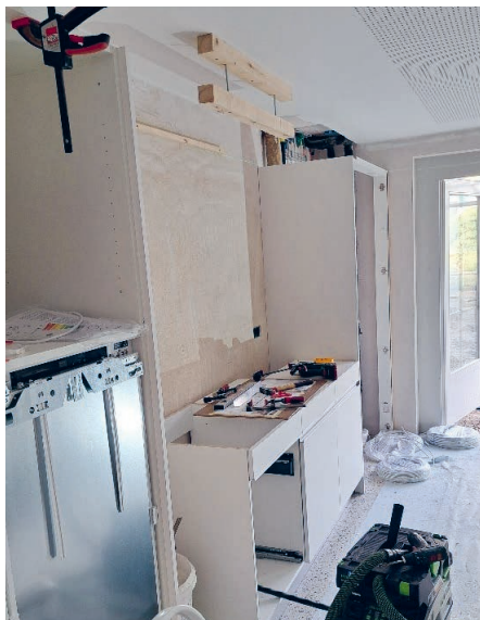
Vorbereitung der Wände und Decken
