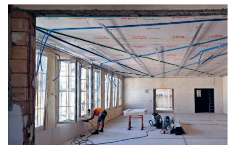
Vorbereitung der Wände und Decken
