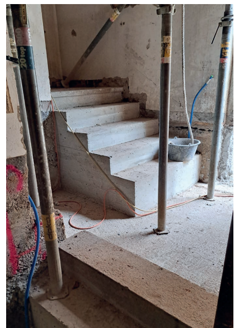
Nach dem Einbau der Bodenplatte im Erdgeschoss geht's nun aufwärts.
